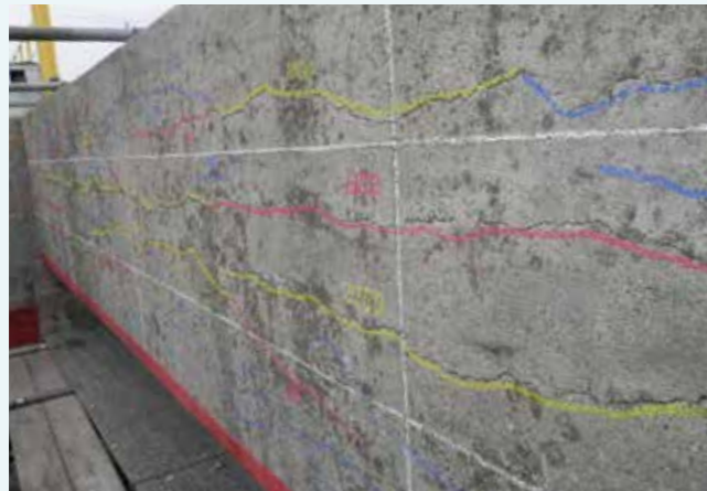
劣化事前調査状況
